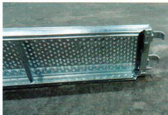
Fotografía 6.8: Detalle de uno de los extremos del tablón.
